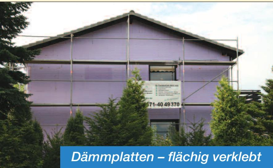
*Dämmplatten – flächig verklebt*
