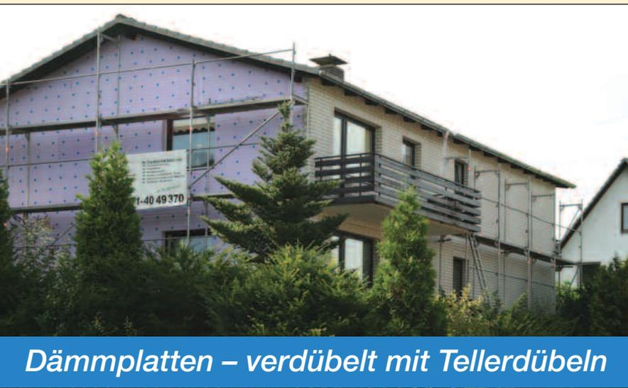
*Dämmplatten – verdübelt mit Tellerdübeln*
